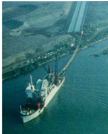
„Stena Apache” Reeling Pipe
